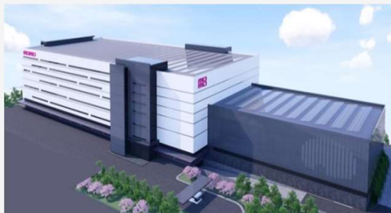
CDC 建造工程於11月動工
