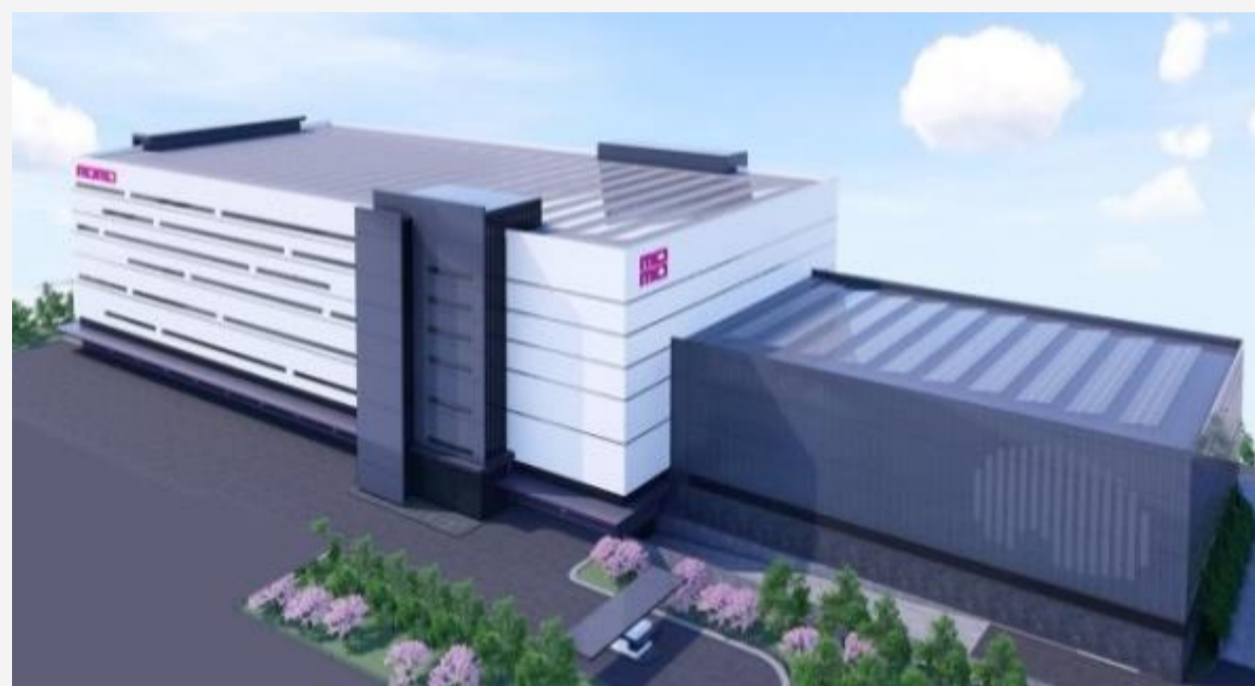
CDC 建造工程於2023/11月動工
