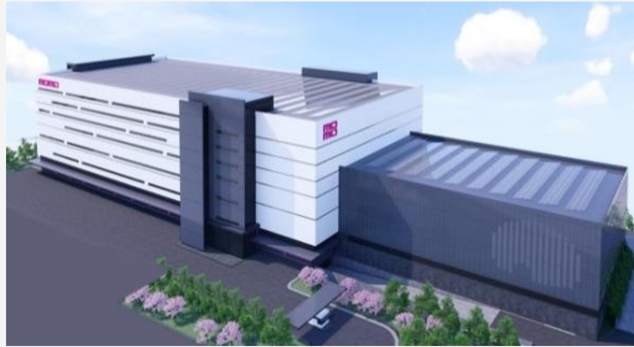
CDC 中區物流中心 建造工程於2023/11月動工
